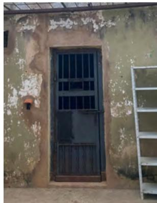
**Foto 277.** Cella em uso, com mofo, sem iluminação, nem ventilação cruzada na UPR Planaltina de Goiás
