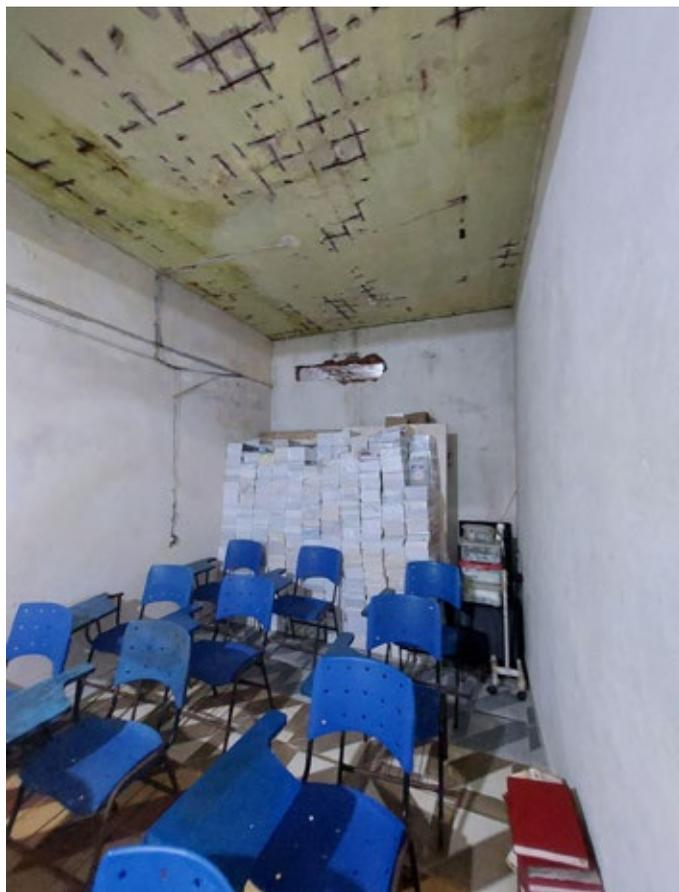
**Foto 37.** Sala de aula em Tefé com infiltrações no teto e paredes e livros sem uso empilhados no fundo.
