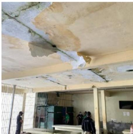
**Foto 46.** Infiltração no teto do COMPAJ.
