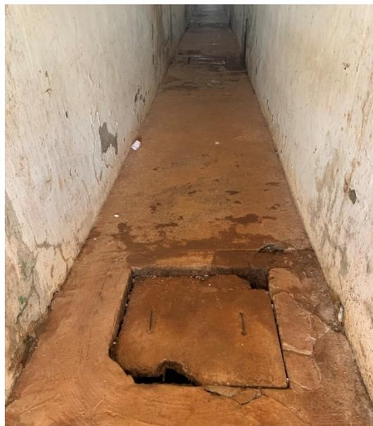
**Foto 14.** Esgoto corre a céu aberto na PIRC.
