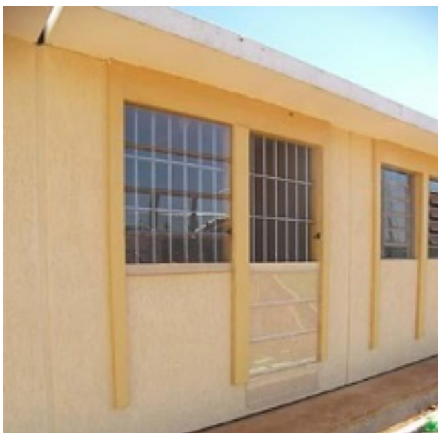
Figura 28: exemplo de esquadria de cela, vazada, com fechamento e controle do usuário. Fonte: catálogo da empre-sa VSIS.
