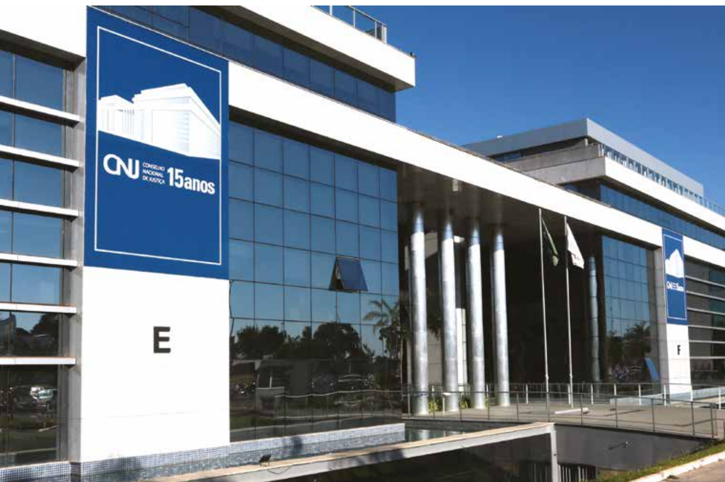
Sede do CNJ (Quadra 2 – SAF Sul)
