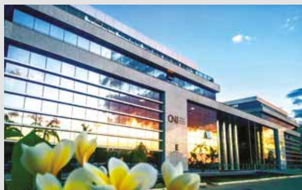
Sede do CNJ desde novembro de 2019 (Quadra 2 – SAF Sul)
