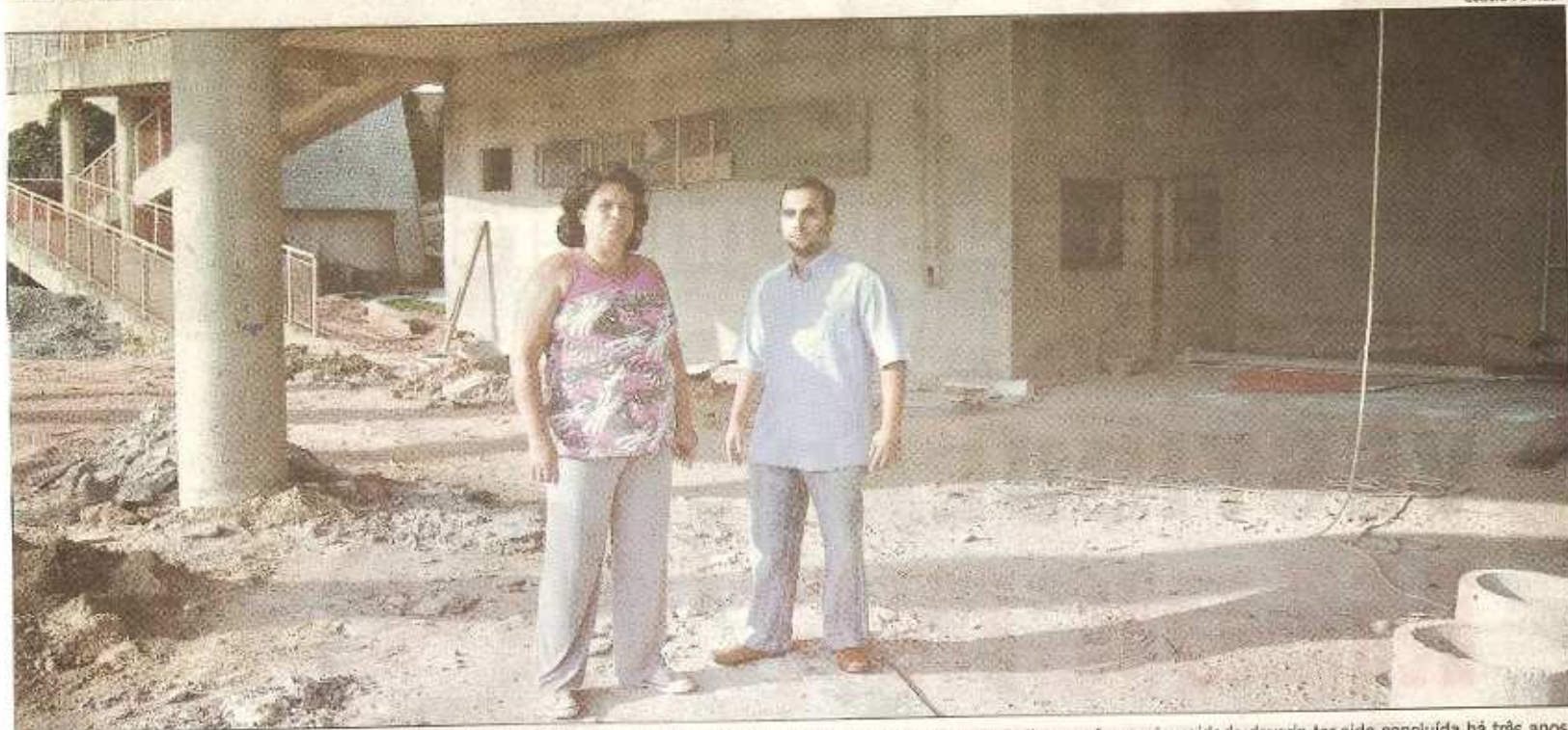
■ ELIANE MARTINS e Bruno Batista, integrantes da Coafisop, no canteiro de obras da Escola Municipal França de Carvalho: a reforma da unidade deveria ter sido concluída há três anos
