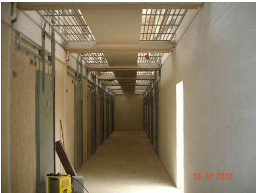
Corredor das celas do pavilhão em construção
