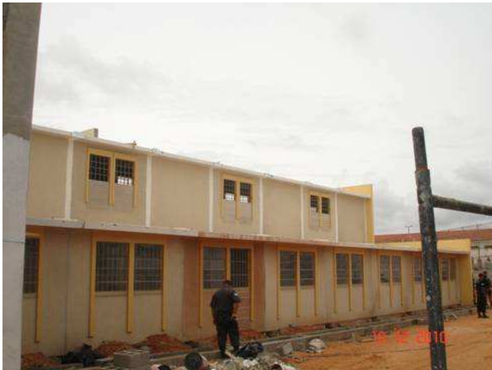
Obras do novo pavilhão
