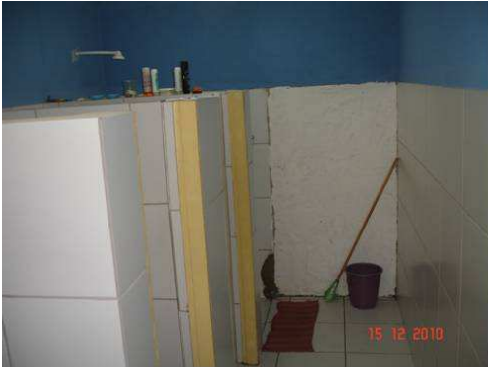
Banheiro da cela
