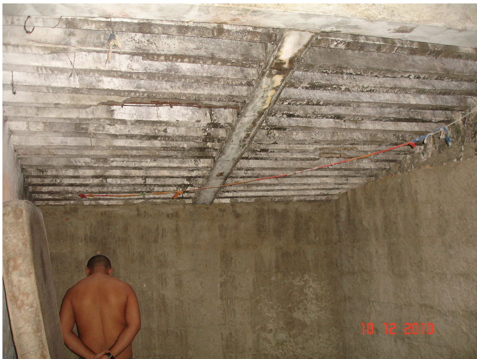
Local do banho de sol também utilizado com alojamento para um interno
