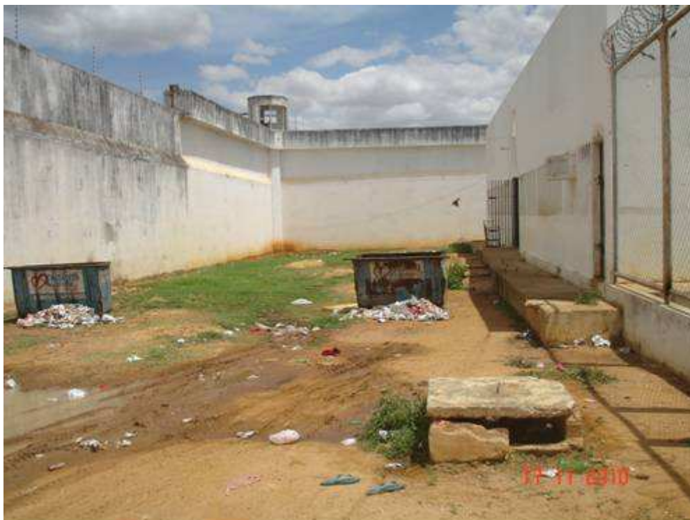
Área externa do pavilhão destinado ao regime fechado com lixo e esgoto ao céu aberto.
