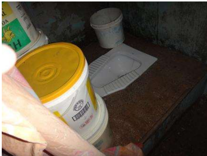
Vaso sanitário da cela
