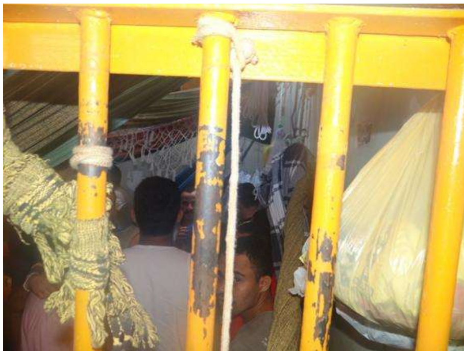
Imagem de uma das celas. Superlotada sem arejamento adequado
