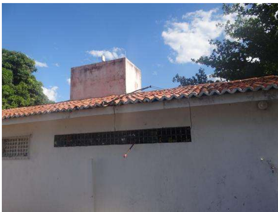
Sistema de arejamento
