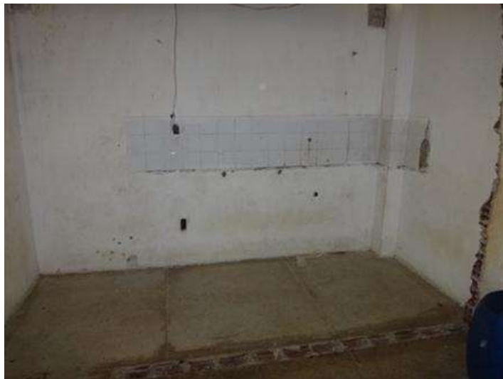
Instalações hidráulicas sem uso
