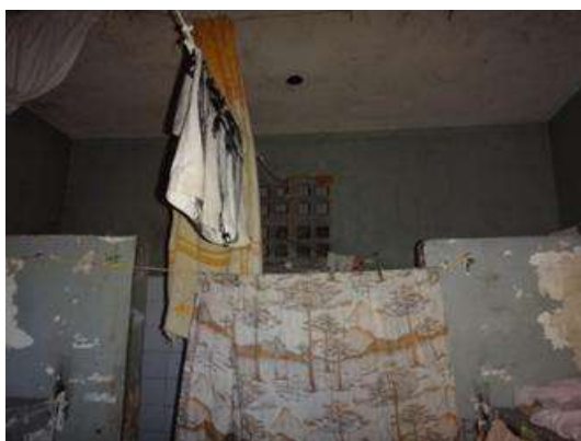
Celas sem ventilação
