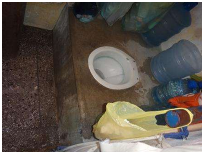
Banheiro das celas
