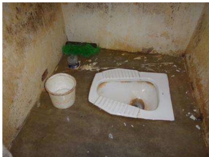
Banheiro da cela
