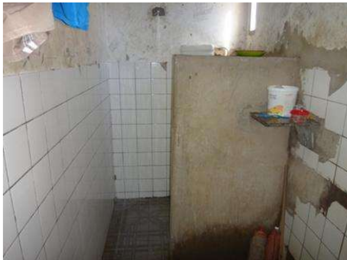
Banheiro da cela
