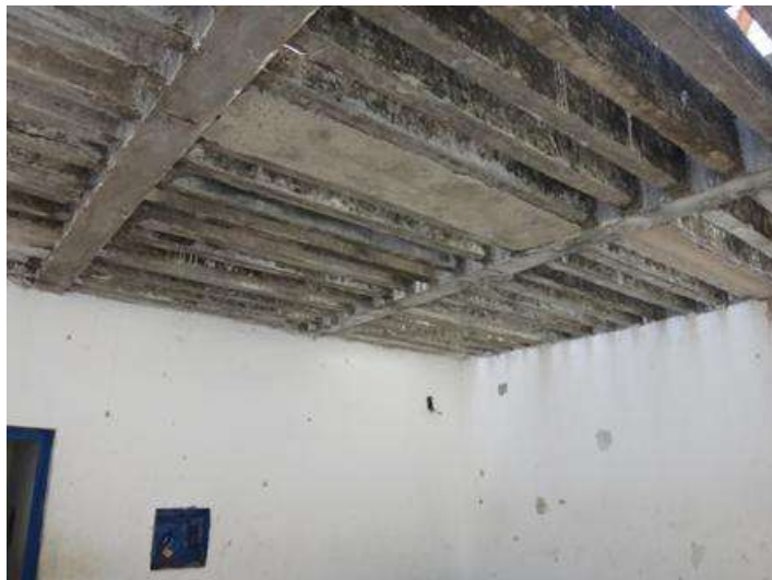
Local de banho de sol.
