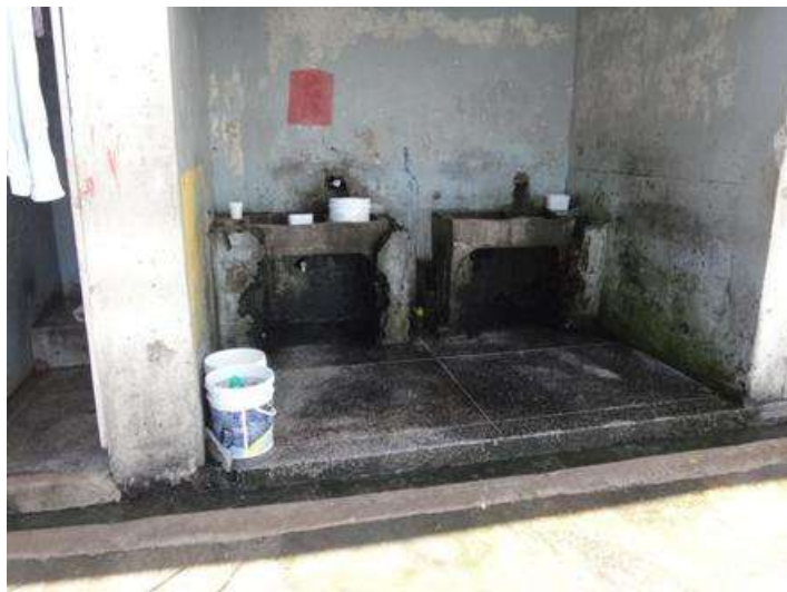
Lavanderia nos pátios de banho de sol
