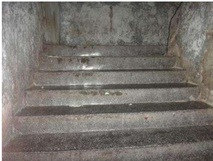
Escada de acesso às celas do pavimento superior
