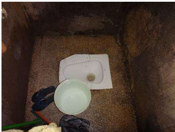
Banheiro da cela
