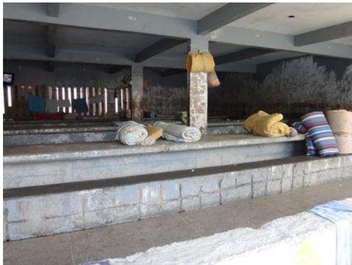
Área de alimentação e visita dos pátios de banho de sol
