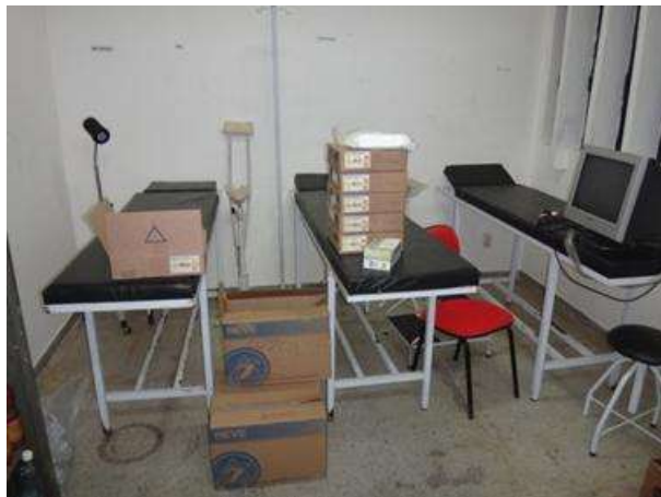
Enfermaria desativada e deteriorando
