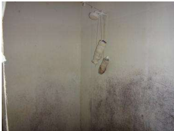
Banheiro das celas
