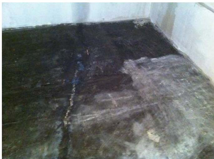
Rachaduras e infiltrações nas celas
