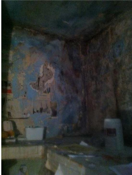
Cela escura sem luz natural e completamente úmida, devido à infiltrações
