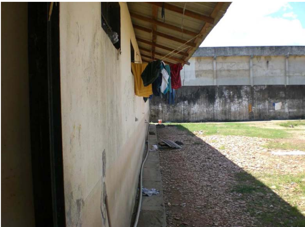
Paredes construídas de tijolos simples
