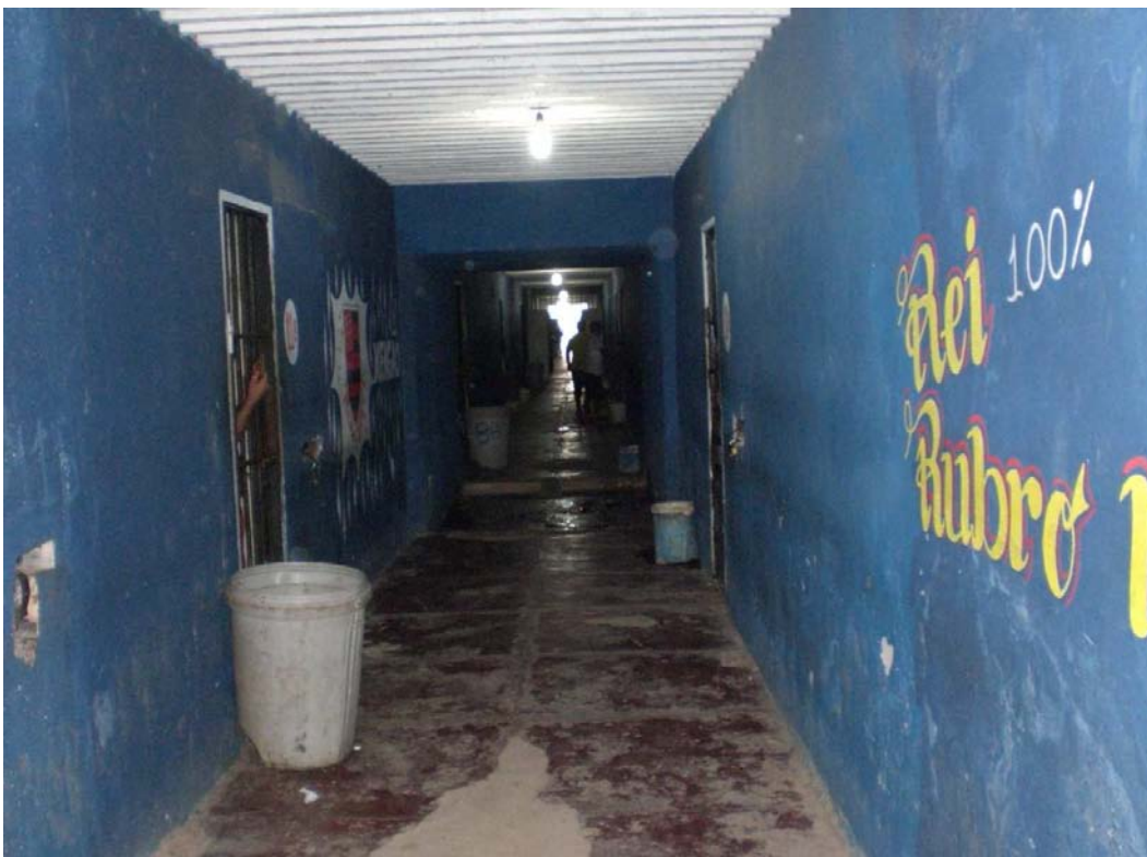
Vista do corredor de um dos pavilhões – pouquíssima ventilação
