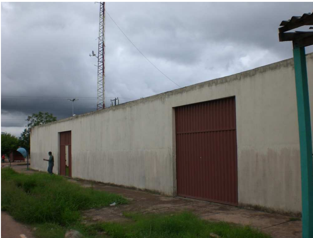
Vista externa do Centro de Custódia
