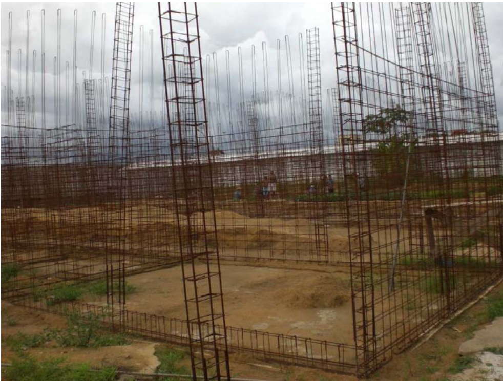
Construção iniciada dentro da penitenciária, mas parada
