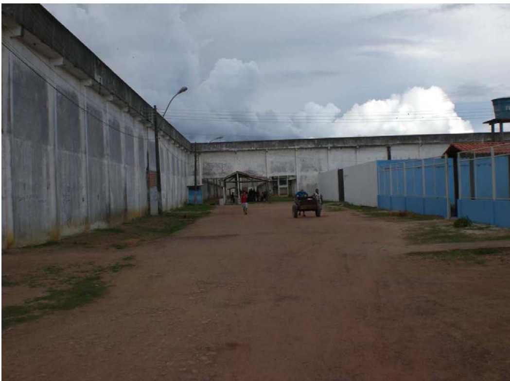
Vista interna da penitenciária-construção antiga
