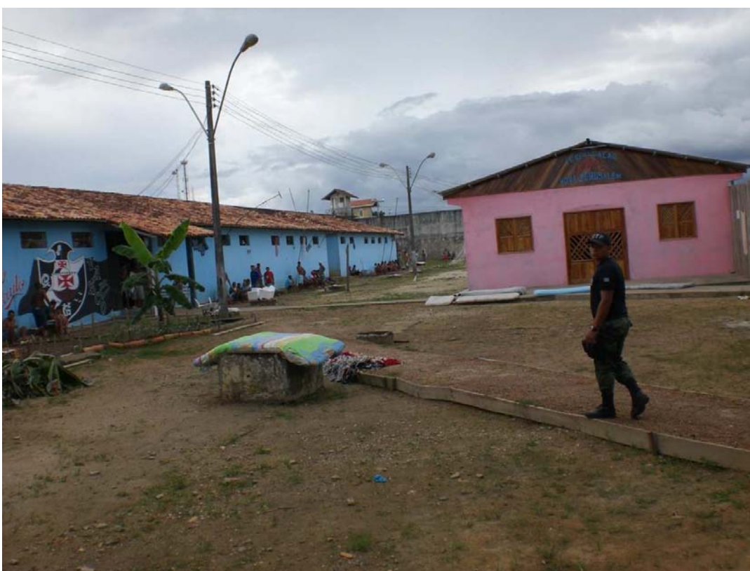
Veja a parte exterior de um dos pavilhões - fragilidade
