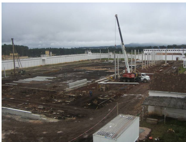
Construção da nova unidade
