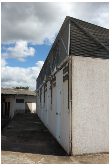
Vista externa das celas
