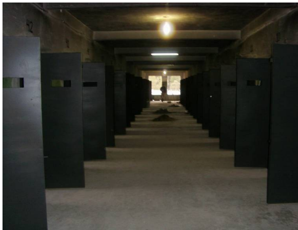
Recuperação das celas destruídas
