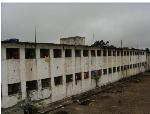
Vista externa das celas
