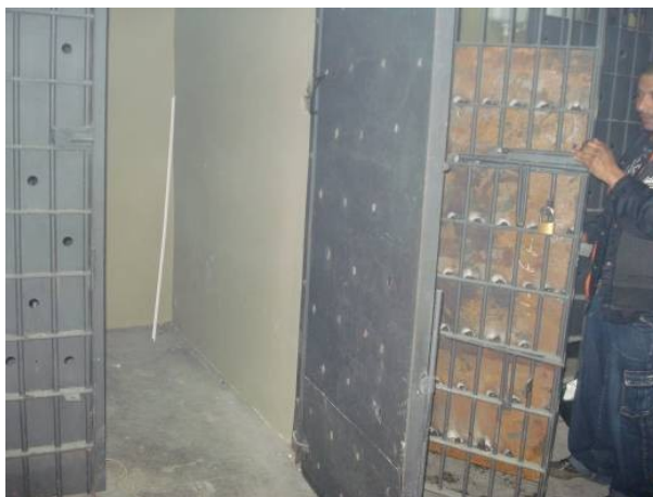
Reforma sendo realizada (colocação de painéis nas portas das celas)
