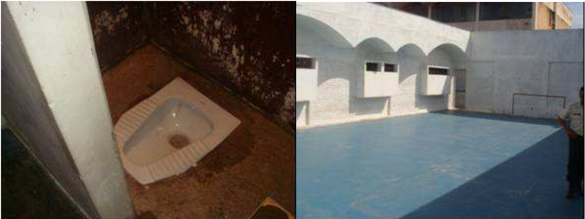
Boas condições de higiene no banheiro e solário da unidade
